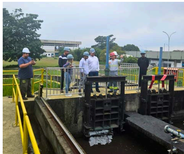
Os alunos de Engenharia participaram de uma visita técnica à Estação de Tratamento de Esgoto (ETE) de Suzano
